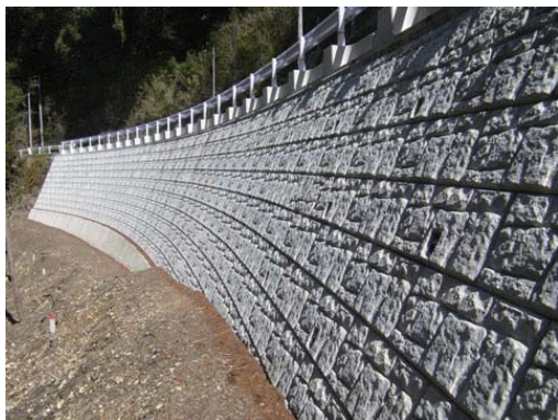
高知県須崎土木事務所四万十町事務所 県道大方大正線活力創出基盤整備総合交付金工事
