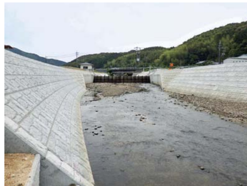
高知県幡多土木事務所宿毛事務所 中筋川(ヤイト川)3か年緊急対策工事
