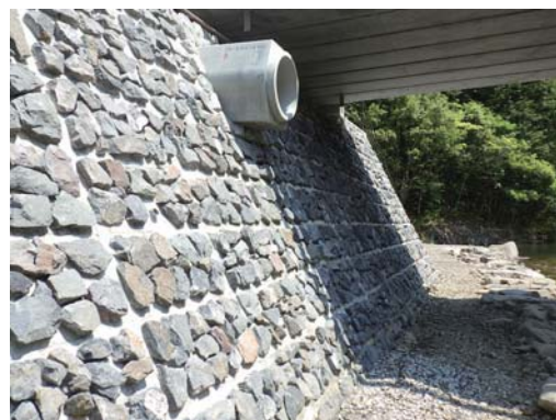
四万十町 町道川ノ内芳川線芳川橋 橋梁下部工事
