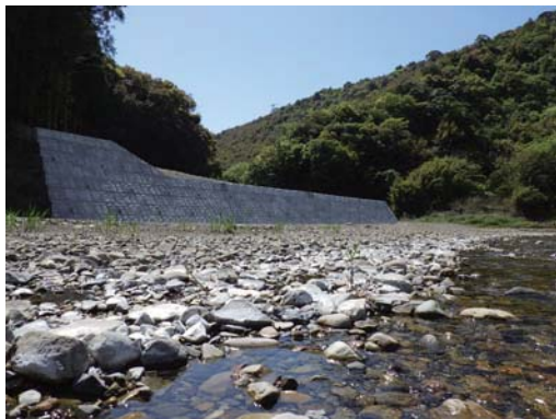
高知県幡多土木事務所宿毛事務所 福良川河川改修工事
