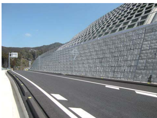
国土交通省 中村河川国道事務所 影野改良第 1 工事
