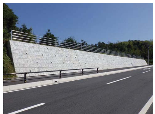
高知県幡多土木事務所宿毛事務所 県道土佐清水宿毛線防災・安全交付金工事
