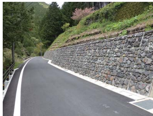
四万十町 町道大奈路中津川線道路改良工事
